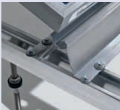
Befestigung des Basisprofils auf der C-Schiene
