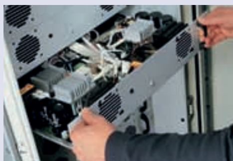
Leistungsteile können wie Schubladen herausgezogen werden.
