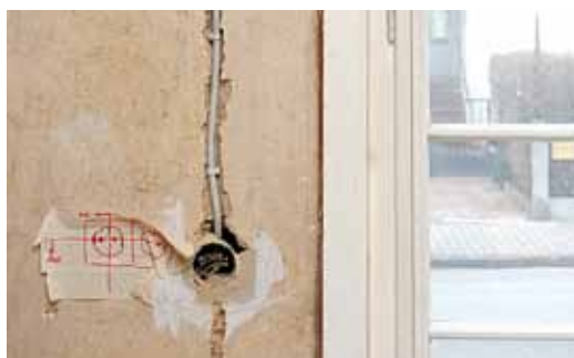
Beim Austausch der Fenster bietet sich die Nachrüstung von elektrischen Rollläden- und Jalousieantrieben an.
